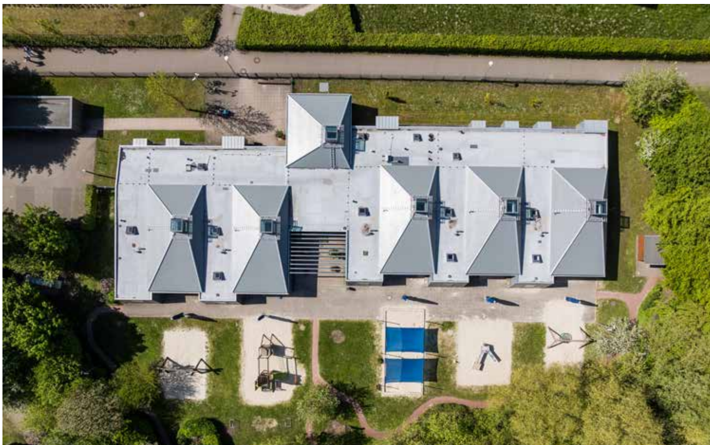
Die Gebäudehülle der Kita Chamäleon wurde mit 32 x 60 cm großen Cedral Dach- und Fassadenplatten in Doppeldeckung ausgeführt. Die feine Struktur der Deckung unterstreicht die klare, geradlinige Architektursprache und bietet zugleich einen dauerhaft robusten Schutz vor Wind und Wetter.
