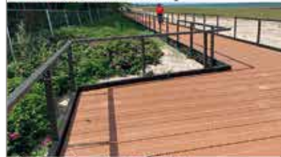
Steg am Strand aus TRIMAX®
