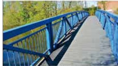
TRIMAX® als Brückenbelag
