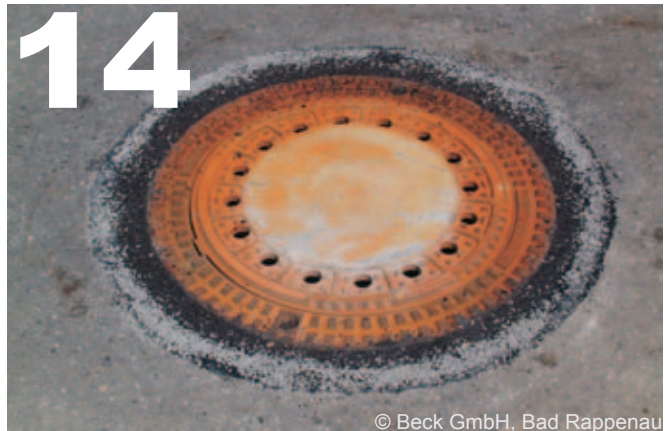
Zur optischen Angleichung absplitten
