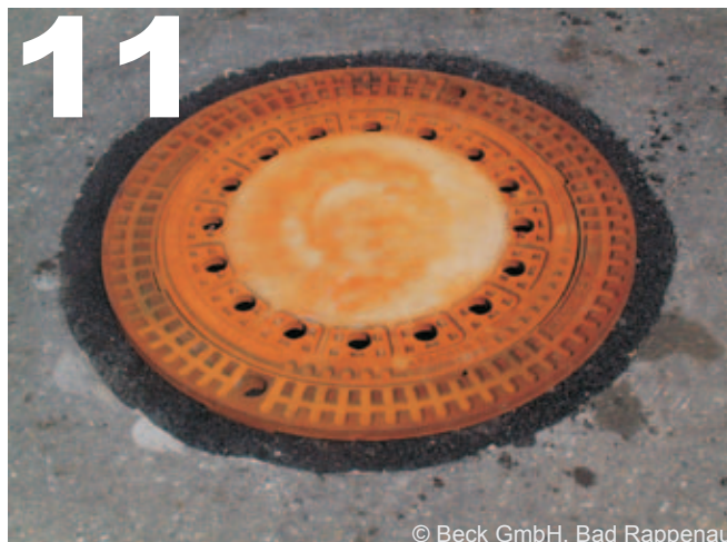
BEGU®-Deckel nach DIN 19584 oder Deckel aus Gusseisen einsetzen
