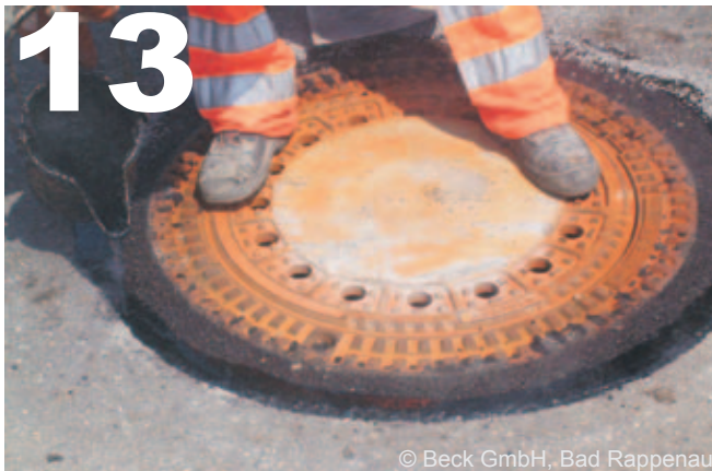
Nahtverguß mit Heißbitumen
