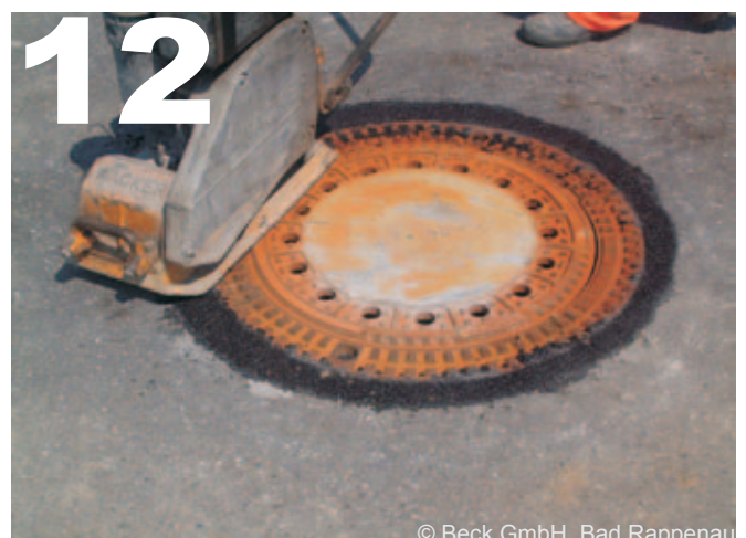
Schachtabdeckung Bituplan® auf Fahrbahnniveau einrütteln
