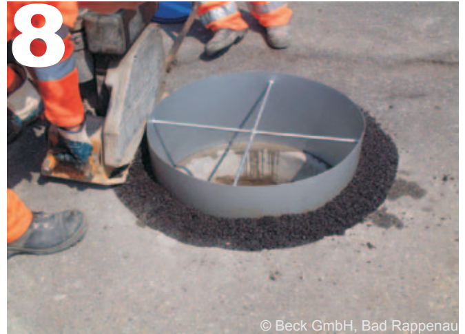
Asphalt vorverdichten
