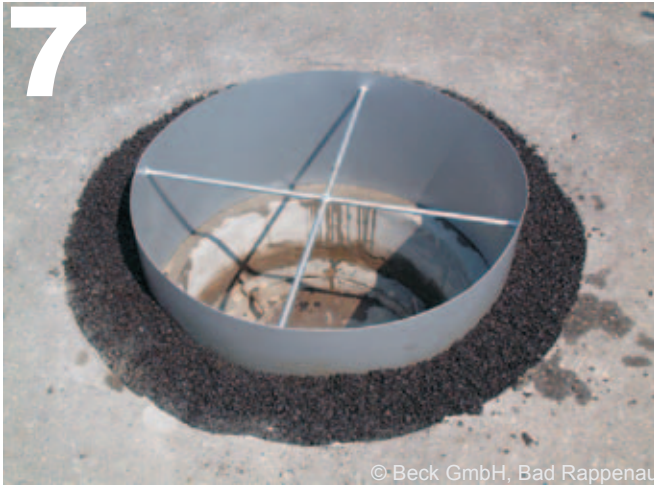
Arbeitsraum mit Asphalt auffüllen
