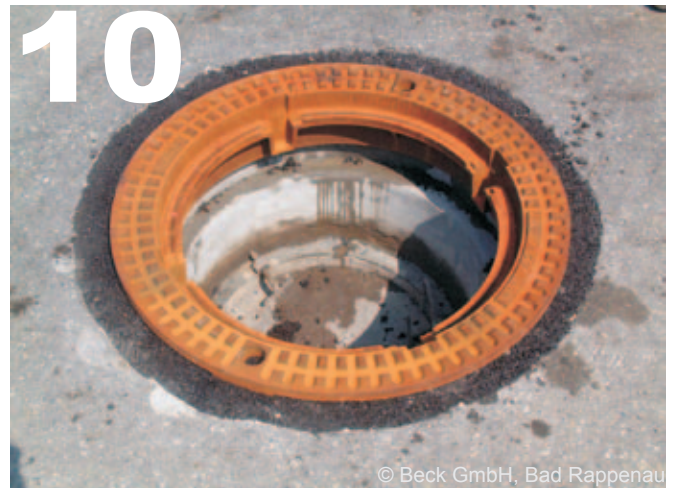
Rahmen der Bituplan® einsetzen
