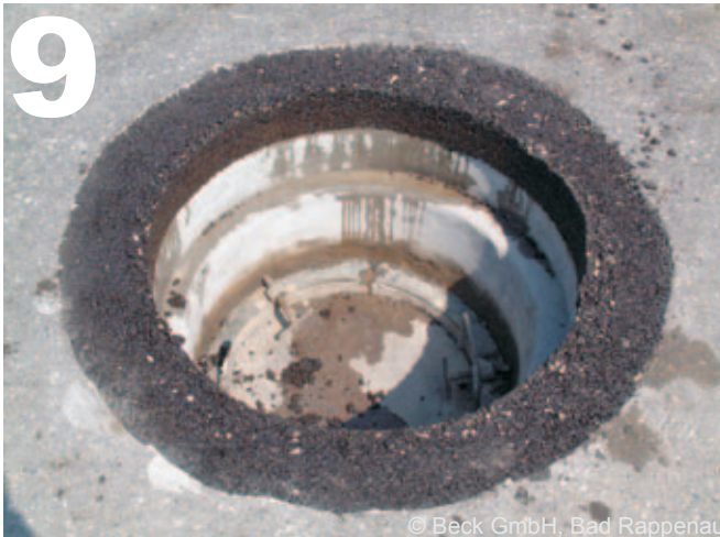
Einbauschalung entfernen
