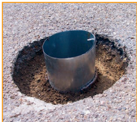
4. Reinigen des Aufbruchs und Einsetzen der Bitumenschalung, anbringen von Haftgrund und/oder Nahtkleber
