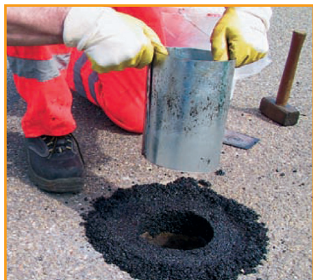
5. Aufbruch mit reaktivem Asphalt verfüllen und vorverdichten
