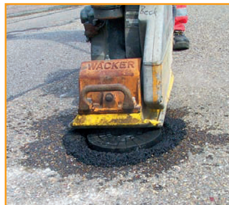
7. Einsetzen der Beck-Straßenkappe
