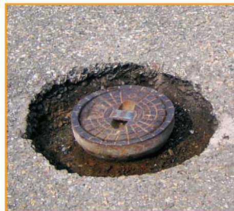
3. Abtrennen des alten Gussoberteils der vorhandenen Straßenkappe
