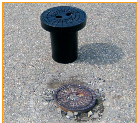
1. Erfassen des Schadensbildes
