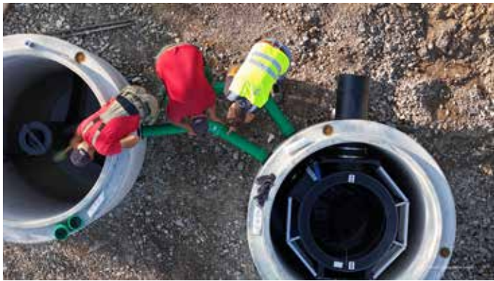
Bei dem Kunstrasenprojekt in Göppingen kam erstmals die neue Leichtstoff-falle von 3P Technik (links im Bild) zum Einsatz, die Mikroplastik und andere Leichtstoffe zuverlässig zurückhält.
