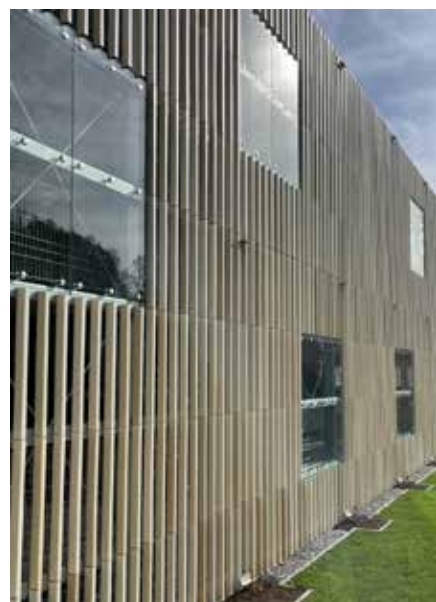
Keramikfassaden zeichnen sich durch ihre einfache Reinigung, den geringen Wartungsaufwand sowie die lange Lebensdauer aus.
