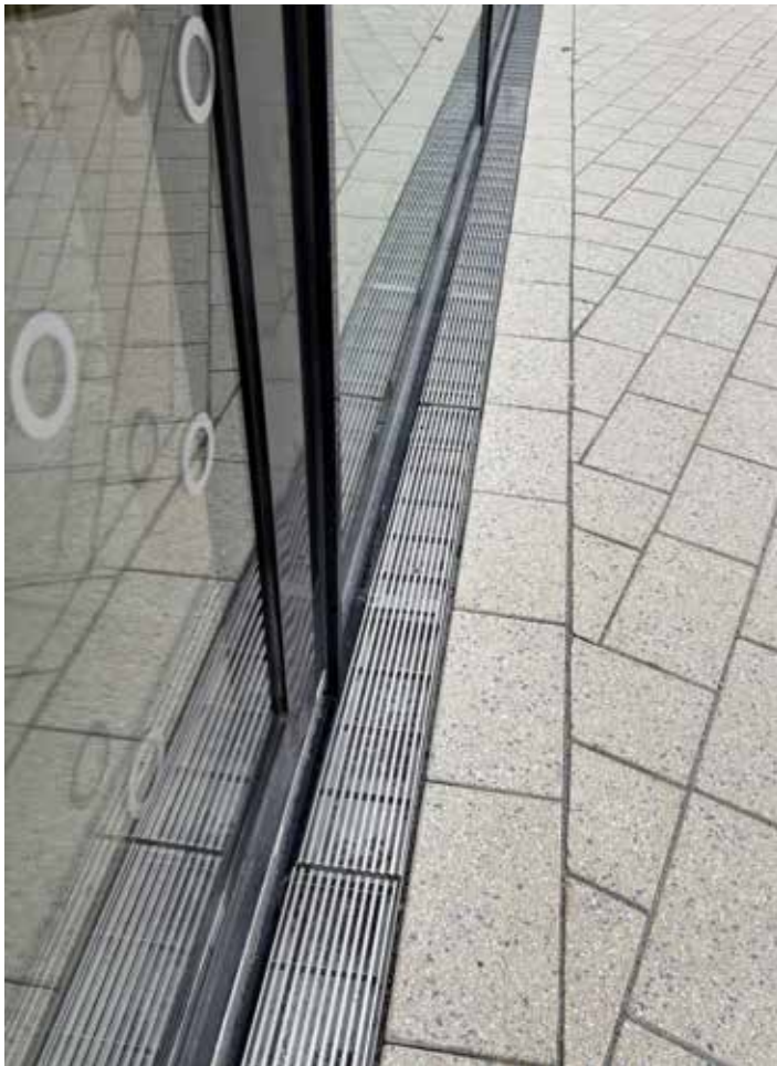
Zur Fassadenentwässerung, vor allem an besonders exponierten Stellen, dienen Entwässerungsrinnen BG-FLEX glass von BG-Graspointner.
