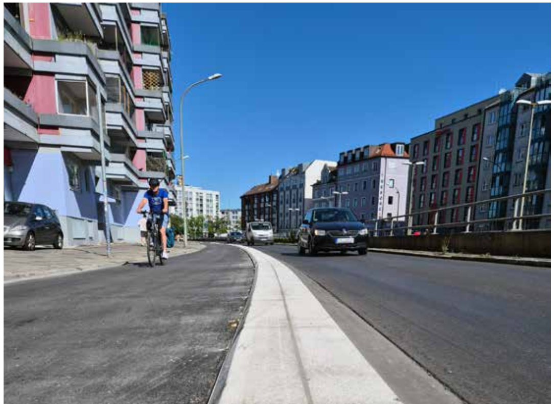
Der Münchner Flachbordstein ist eine neue Form der baulichen Abgrenzung zwischen Radweg und Fahrbahn. In München-Obergiesing hat die Stadt den Münchner Flachbordstein erstmals entlang der südlichen Tegernseer Landstraße eingebaut.
