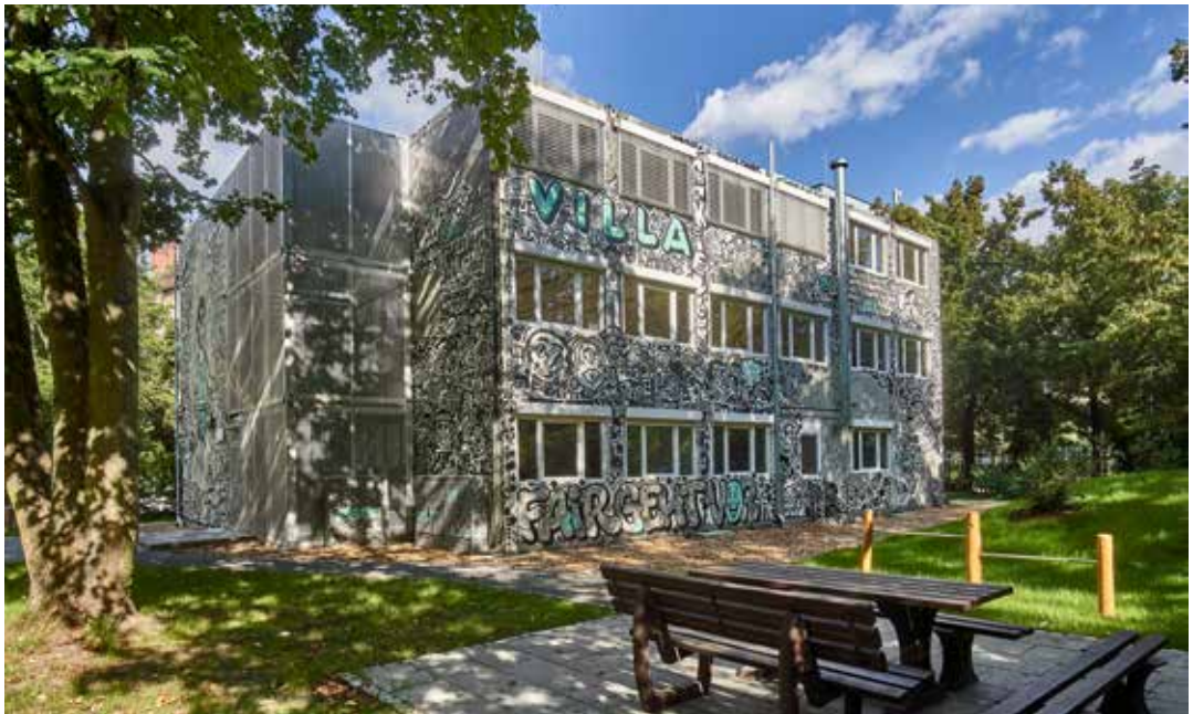
Das dreigeschossige Gebäude besteht aus 51 Modulen. Nach Fertigstellung wurde die Fassade von Graffiti-Künstlern gestaltet. Bildquelle: action press – Jochen Zick
