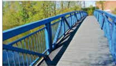
TRIMAX® als Brückenbelag
