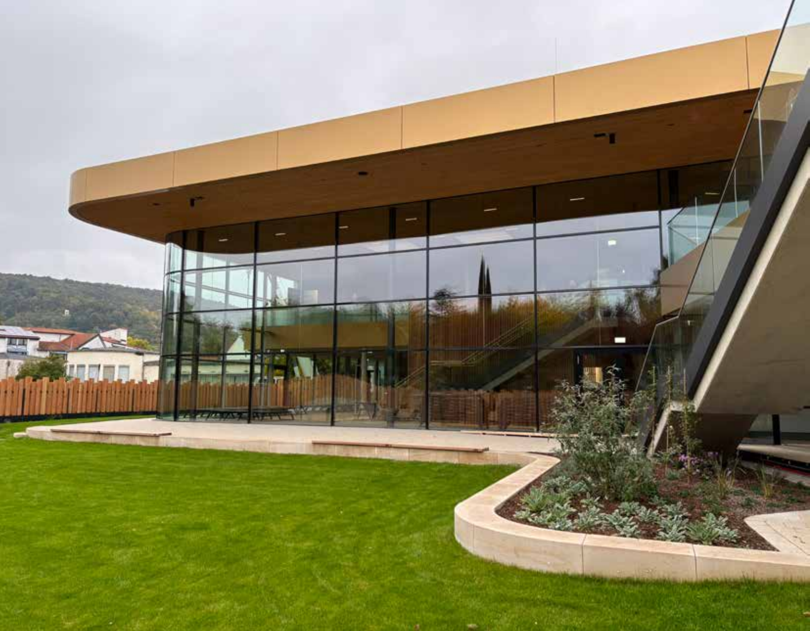
Im Eingangsbereich schützt das weit auskragende Dach vor Niederschlag.
