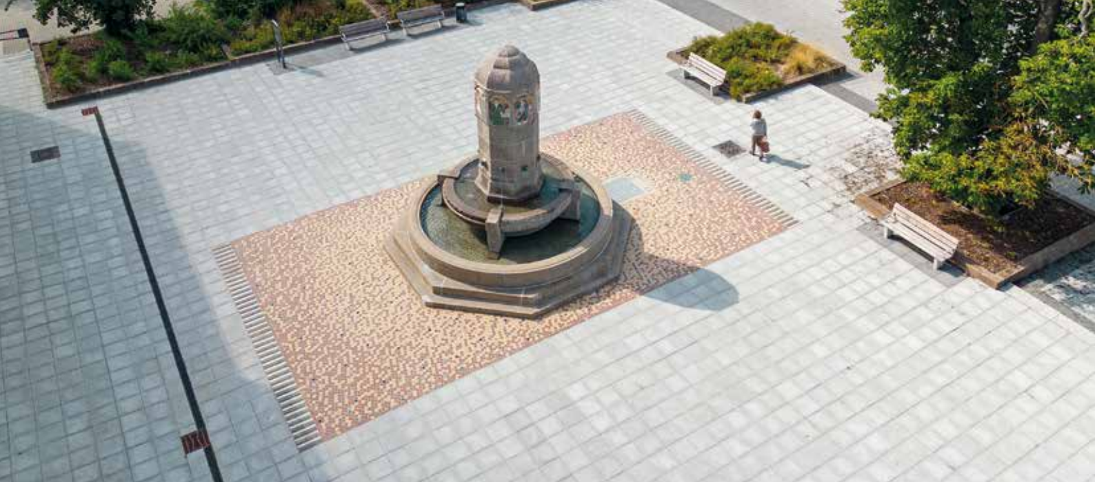
Der sanierte Platz um den Rostocker John-Brinckman-Brunnen: Ein kunstvoll gemusterter Ziegelteppich aus GIMA Pflasterklinkern rahmt das historische Denkmal ein. Foto: Berthold Brinkmann
