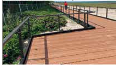
Steg am Strand aus TRIMAX®
