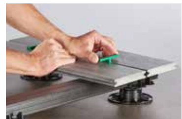
4. Richtige Verlegehilfe einsetzen
