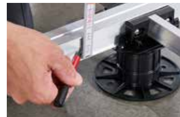
2. Löcher (6 mm) mittig in UK bohren
