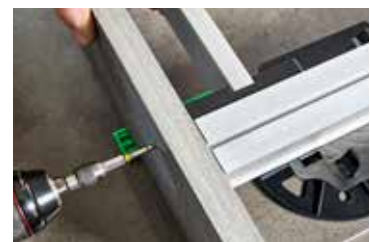
1: Blendenbefestigung mit Profilverstärker siehe S. 28–29
