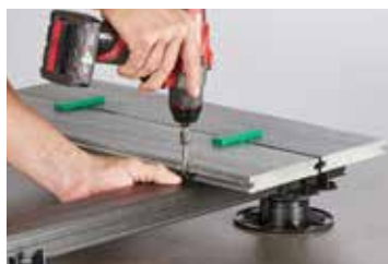
5. Weitere Klammern montieren
