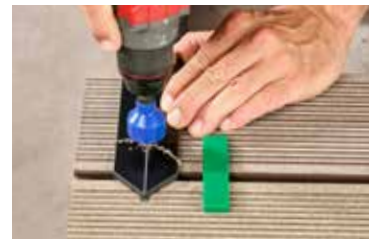
2. Bohrlöcher mit Bohrer markieren
