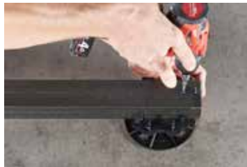
1. Anfang-/Endklammer montieren
