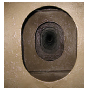
Zweite Schicht - PERMA FILM Buff mit 250 µm (wft.)
